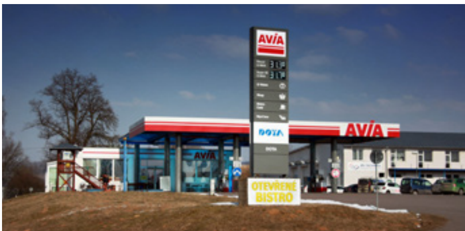
Součástí rozrůstající se sítě AVIA se stala i soukromá čerpací stanice Dota v Lanškrouně.
