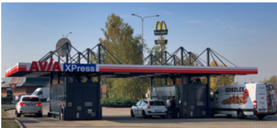
Součástí sítě AVIA jsou také samoobslužné čerpací stanice AVIA XPress. Jedna taková stojí na pražském Zličíně.
