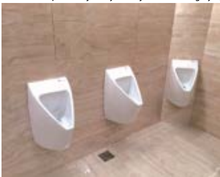
Bezvodé pisoáry mohou ušetřit velké množství vody
