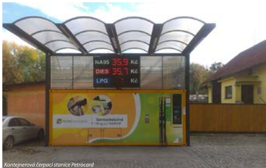
Kontejnerová čerpací stanice Petrocard
