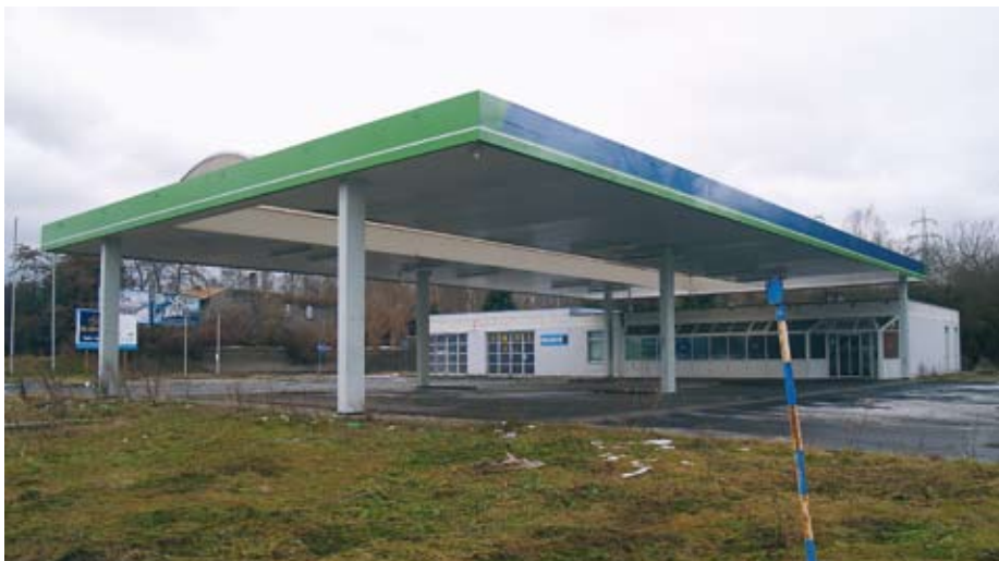
Dříve monumentální, vysokokapacitní čerpací stanice, dnes mrtvý památník zlatých časů.
