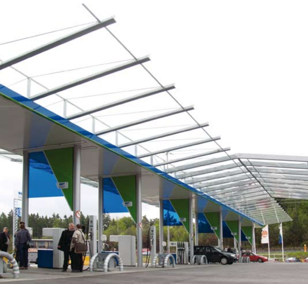
První čerpací stanici s tlakovým systémem v ČR postavila na začátku 90. let společnost OMV u D1 v Pávově. Mnozí řidiči navyklí na rychlé vrčení stojanu při tankování z ultratichého chodu stojanů na této pumpě znejistěli, zda produkt opravdu vytéká z výdejní pistole.
